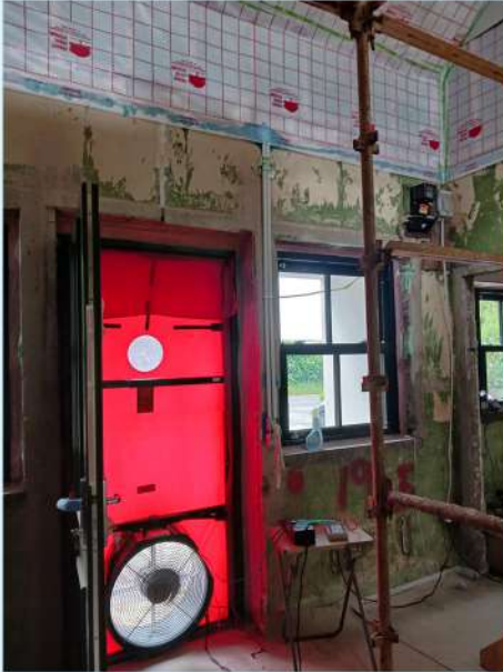
Blower Door Test
